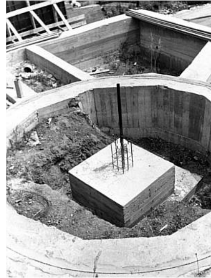
Figura 20 – Le fondazioni in cemento armato con il plinto indipendente (15 giugno 1974)
