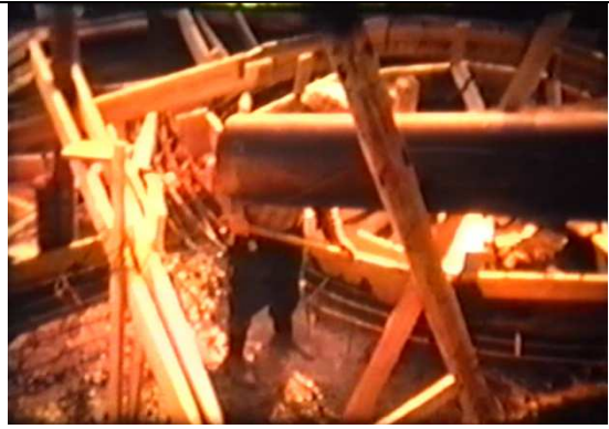
La preparazione per il getto delle fondazioni: si notano la tramoggia, i casseri di contenimento in legno e le barre metalliche di armatura
