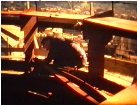
La fase di assemblaggio dell'ossatura metallica della cupola principale
