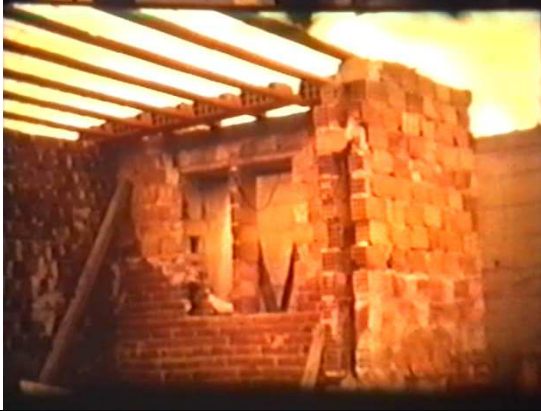
L'impostazione del solaio fra piano seminterrato e piano principale, nella zona dei futuri servizi igienici
