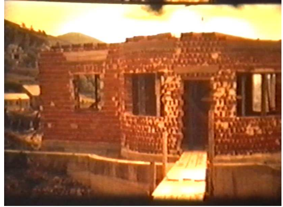
Le pareti perimetrali al piano principale, ancora al grezzo.
